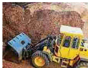
Die Holzschnitzelheizzentrale der Hebbag in Balterswil.
